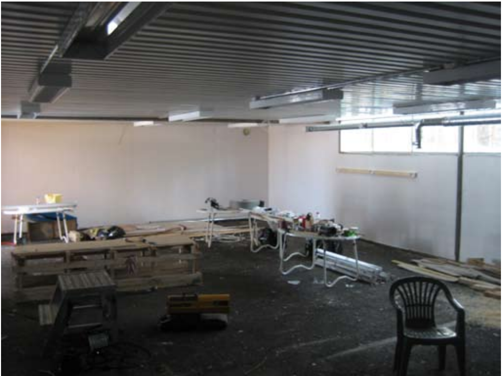
Kunnostettua hallia sisältä.
