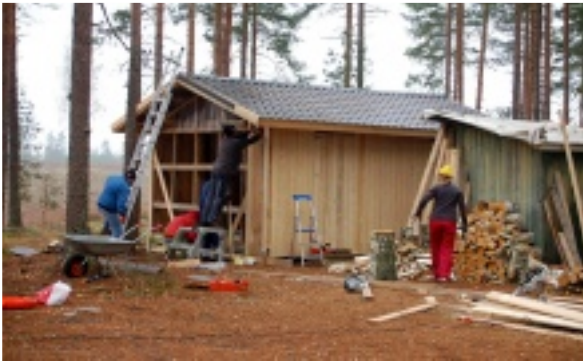
Puuliiterin rakentelua Oripäässä, mallia J. Turta (kuva Esa Parviainen 17.10.2009)
