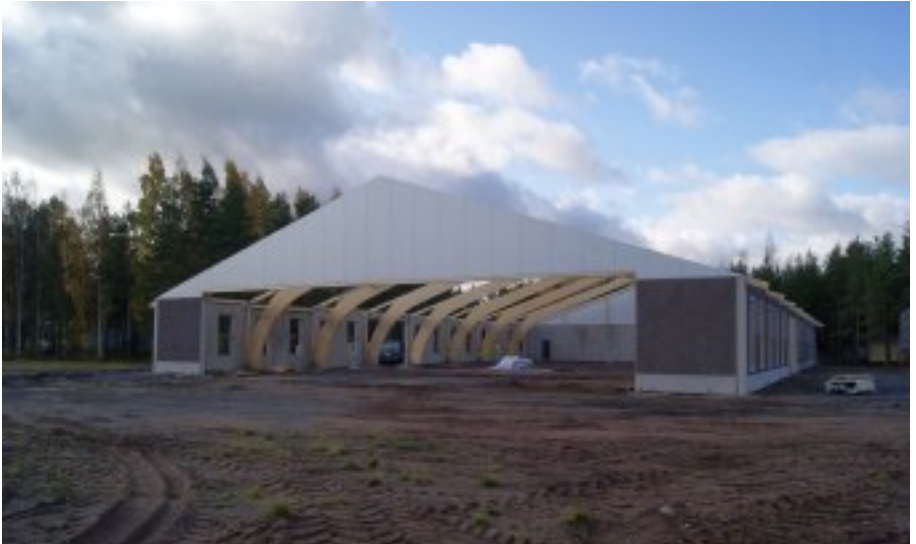
Oripään uusi halli rakenteilla (kuva Matti Autio 7.10.2011)
